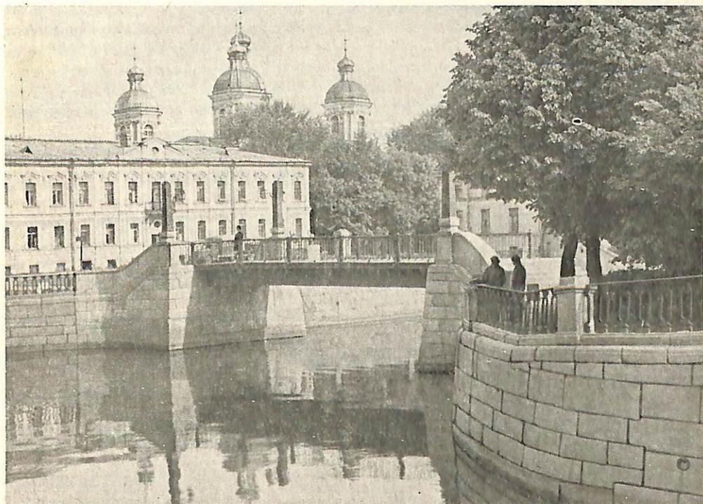
Мост железобетонный, по фасадам декорирован чугунными карнизами. Пролетное строение в виде двухшарнирной рамы, рассчитано под пешеходную нагрузку и два теплопровода. Полная длина моста — 17,9 м, ширина — 4,5 м.
