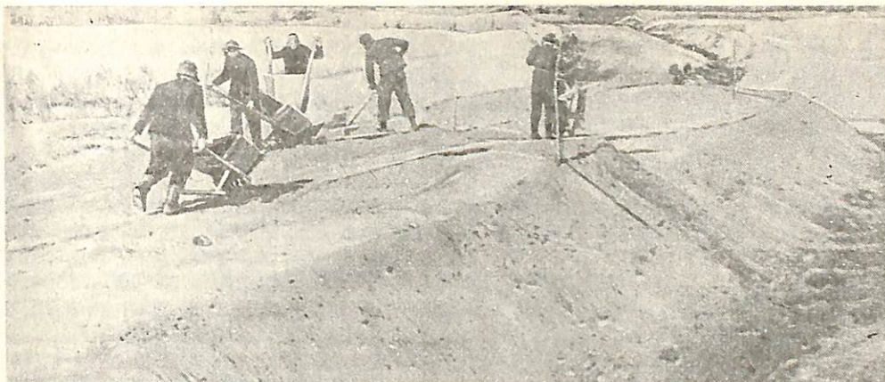
Заключенные на отсыпке земляного полотна. (Публикуется впервые)
