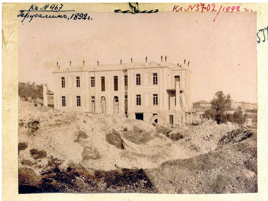
Рис. 6. Консульский дом в процессе строительства, 1892 г. АВПРИ.
