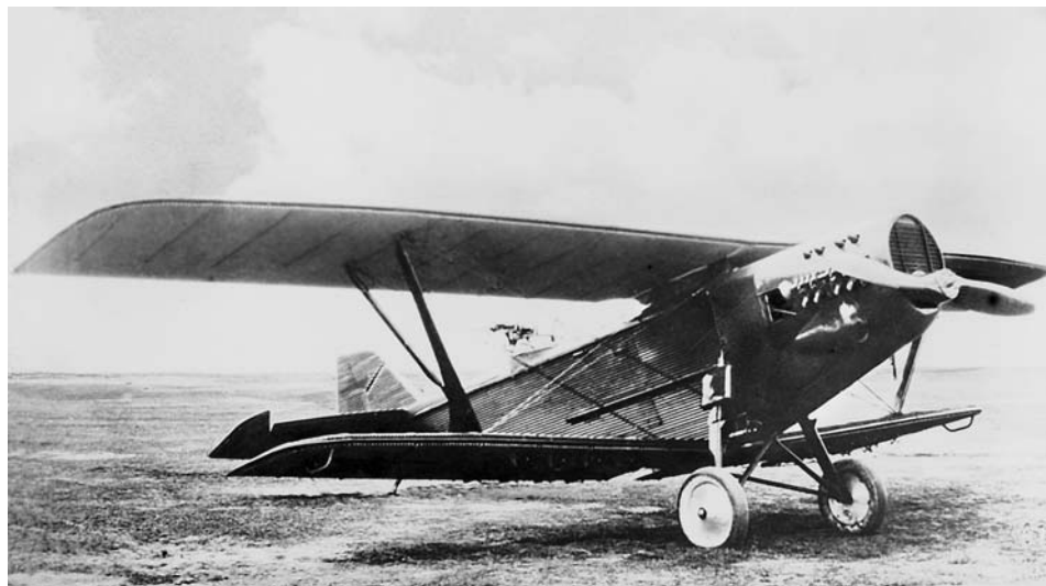
Рис. 7. Разведчик Р-3 – первый в СССР серийный цельнометаллический самолет
